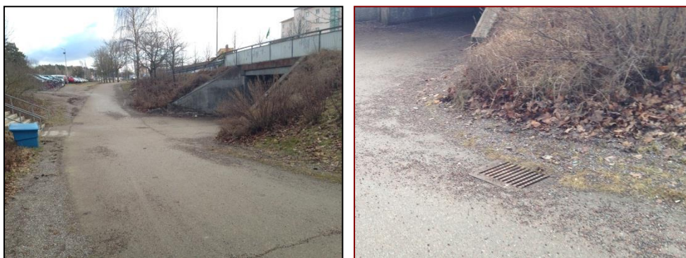
Figur 10. Bilden till vänster visar GC-vägen under Stockholmsvägen och bilden till höger visar en rännstensbrunn (Norconsult 2014)
