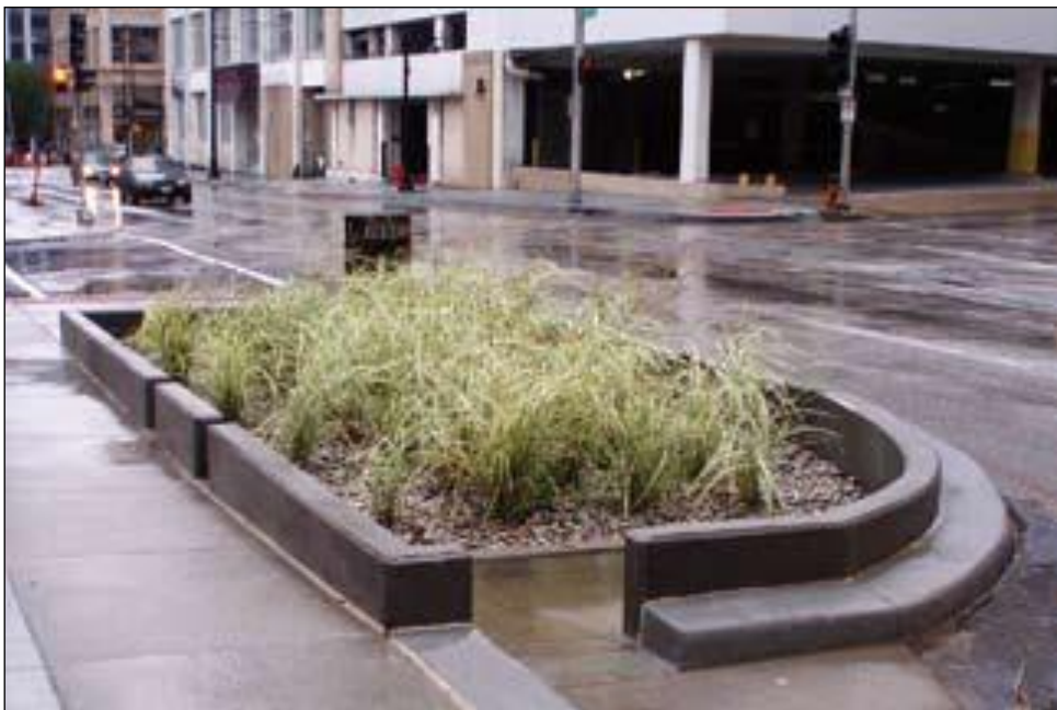
Figur 21. Exempel på Rain garden längs en väg, observera utformning av kantsten (VegTech)
