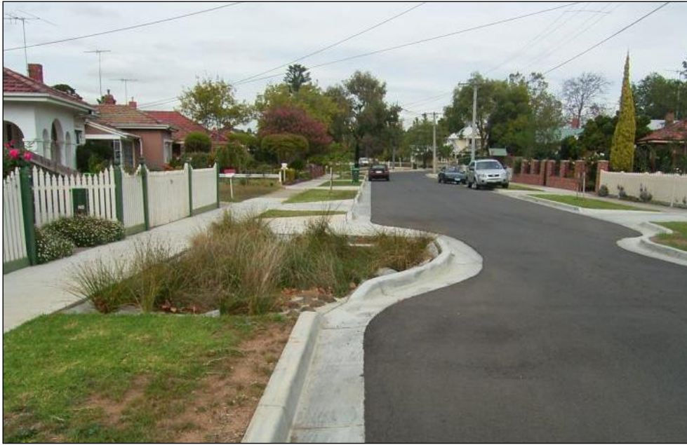
Figur 22. Exempel på gröna öar, observera utformning av kantsten
