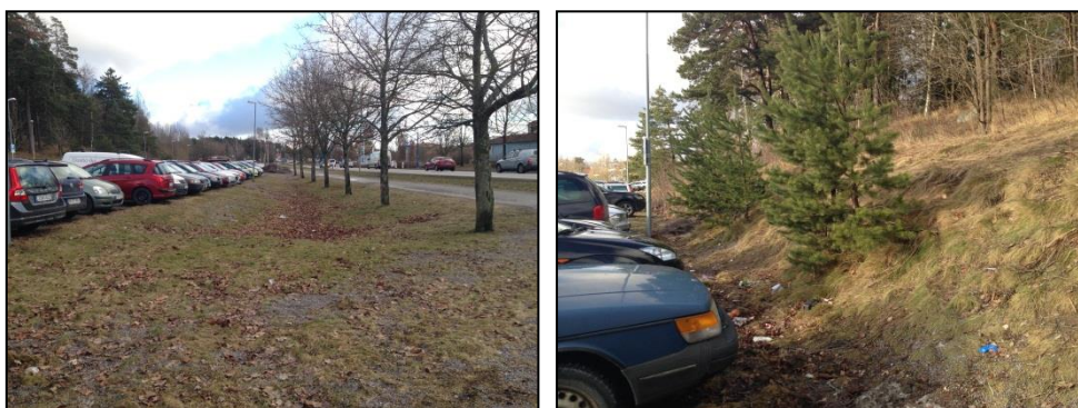
Figur 11. I bilden till vänster visas svackdiket mellan parkeringen och gång-cykelvägen och till höger det avskärmande diket mellan naturområdet och parkeringen (Norconsult 2014)
