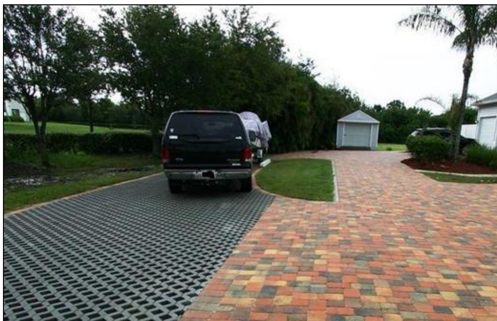
Figur 20. Parkeringsyta med hålsten i betong
